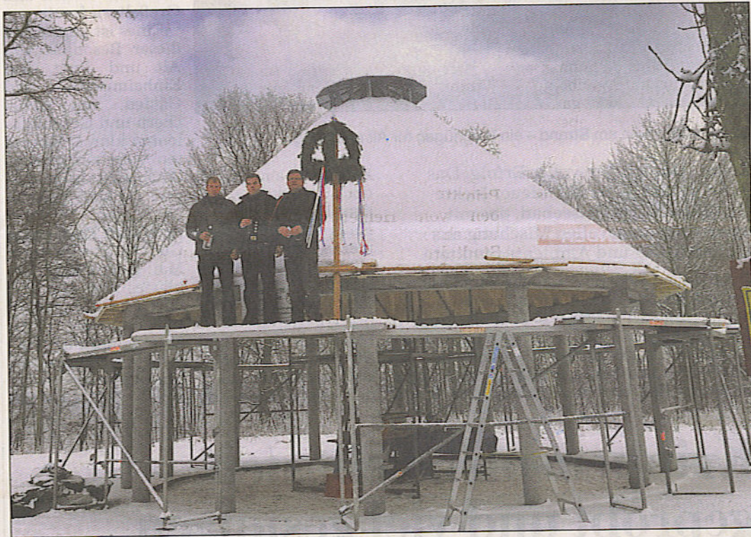
Richtkrone statt Adventskranz: Mit einem Richtfest feierten die Handwerker und die Freunde des Plöner Prinzenhauses den Abschluss des ersten Bauabschnitts für die Wiederherstellung des historischen Apfelgartens im Schlosspark Foto Schneider
